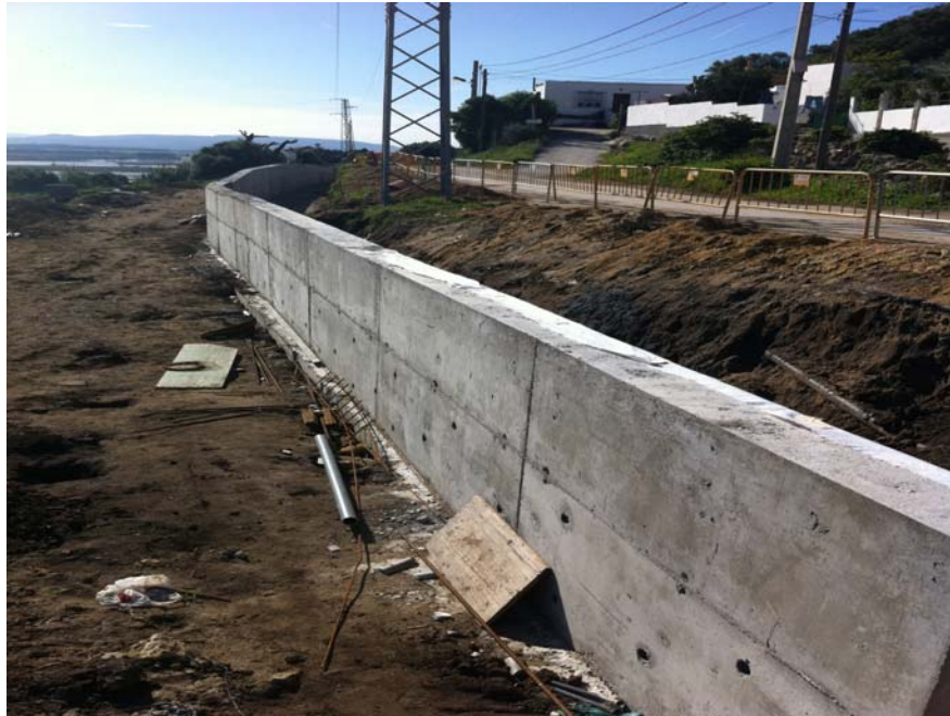
FOTO 1.- vista de la fase anterior en donde se construye la contención de tierras prevista.
