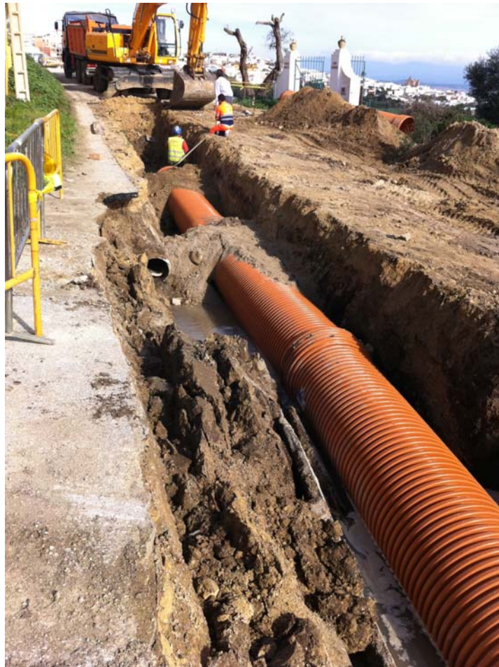
FOTO 3.- vista de la fase anterior en donde se construye la red de saneamiento.
